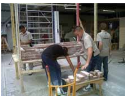
Nog een paar steentjes en wat cement....en het metselwerk zit erop!
