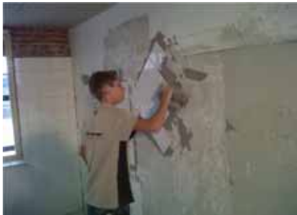
Geconcentreerd een wandje aan het tegelen bij Stichting Haagbouw
